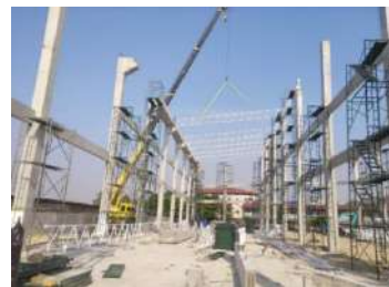
งานติดตั้งโครงหลังคา
