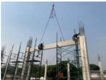
งานติดตั้งคาน Precast
