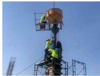
งานเทคอนกรีตเสา
