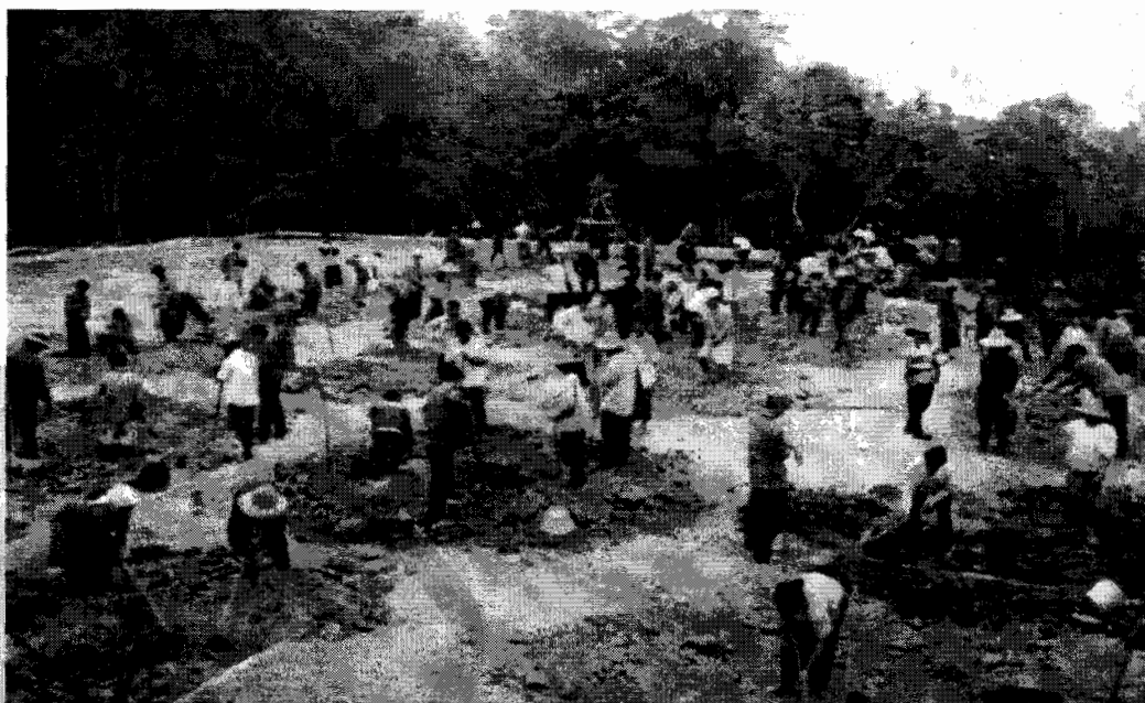
ภาพที่ 19 ชาวบ้านร่วมแรงร่วมใจเตรียมสถานที่ก่อสร้างโรงเรียน - พระปริยัติธรรม
