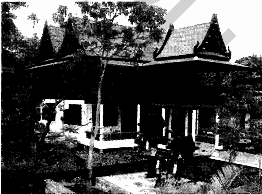
ภาพที่ 4.30 ลักษณะของบ้านทรงไทยแบบประยุกต์ เป็นเรือนไทยครึ่งตึกครึ่งไม้
